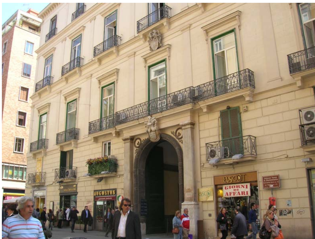
Napoli. Palazzo Tocco di Montemiletto. Prospetto principale su via Toledo
