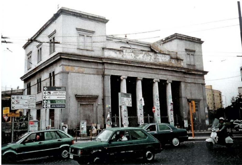
Napoli. La barriera di Capodichino riadattata a sede di un istituto scolastico. Prospetto principale
